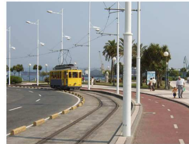
Luminarias, Ciclovías y Tranvía
